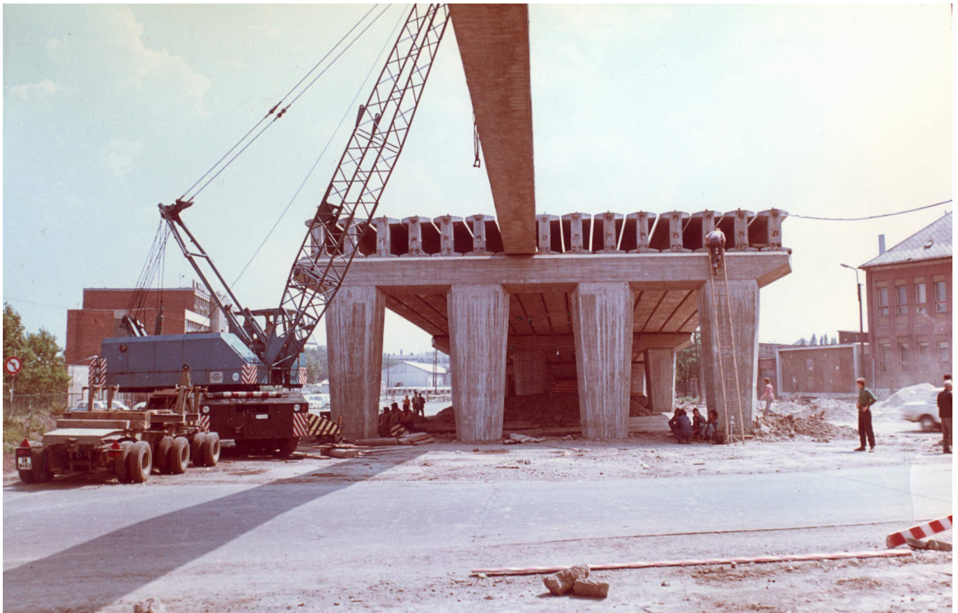
Mi épült 50 éve, 1973-ban: Előregyártott, utófesztett, vasbeton hídgerenda beemelése Pécsen
